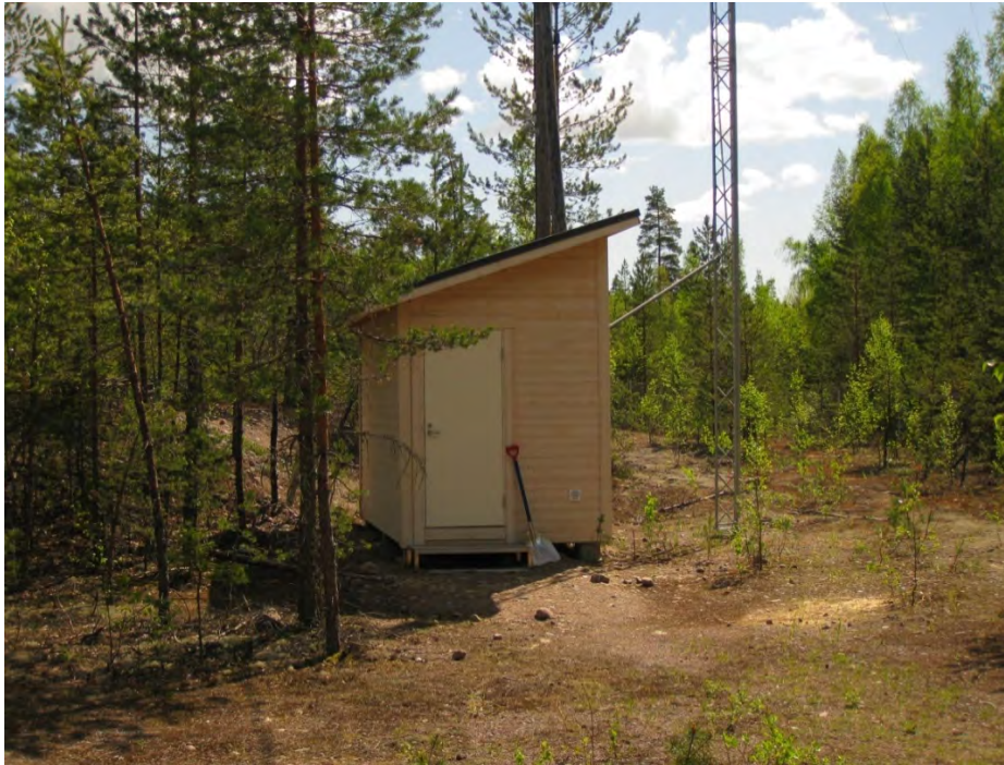
Kuva 4. Marsin pohjavedenottamo Nurmijärvellä.
